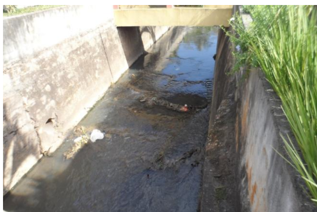
Figura 1. Terceiro ponto de coleta do rio Carambeí, demarcado na Avenida Antonino Dias Bastos (foto tirada em agosto/2013).
